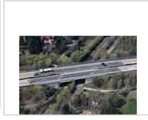
Unterquerung der A 29 bei Sandkrug
